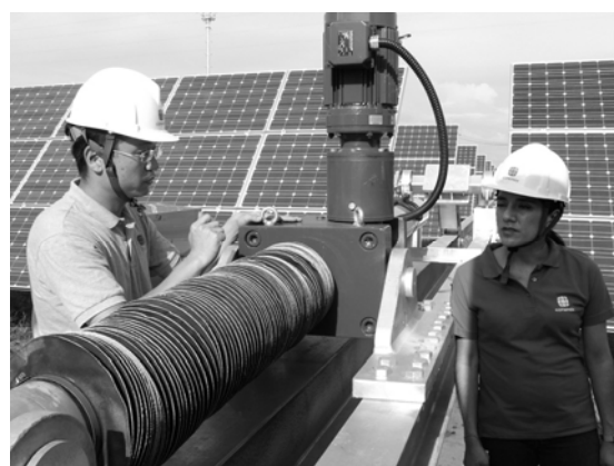
ABATIR PANELES SOLARES
